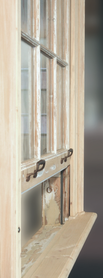
geen aanpassingen aan kozijn enkel vastschroeven van VR Strips in spinning
